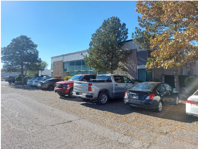
Existing L. A. Roser Building
